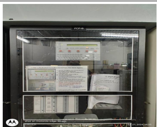
รูปที่ 2.5.7-10 ตู้ควบคุมระบบแจ้งเตือนเหตุเพลิงไหม้อาคารB
